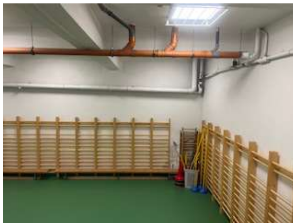
páramentesítő készülék telepítésének helye oldalfalra
